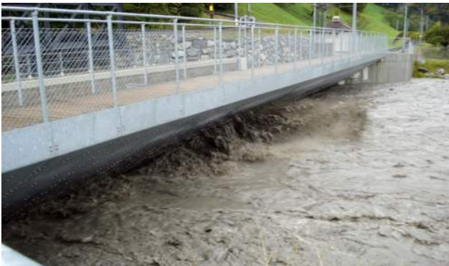
Beispiel Brücke mit Druckabfluss
